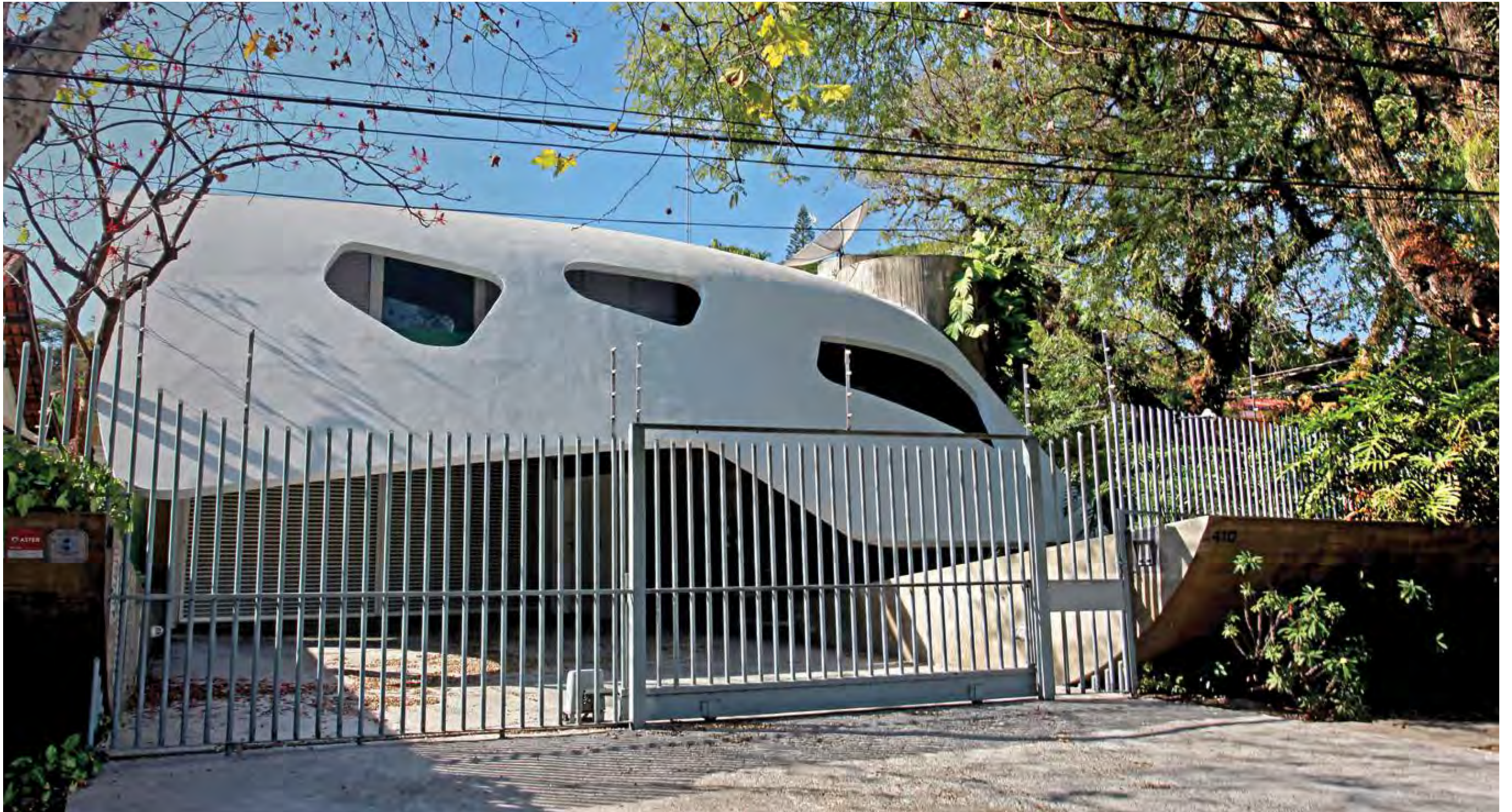
Casa na rua Carlos Norberto de Souza Aranha
