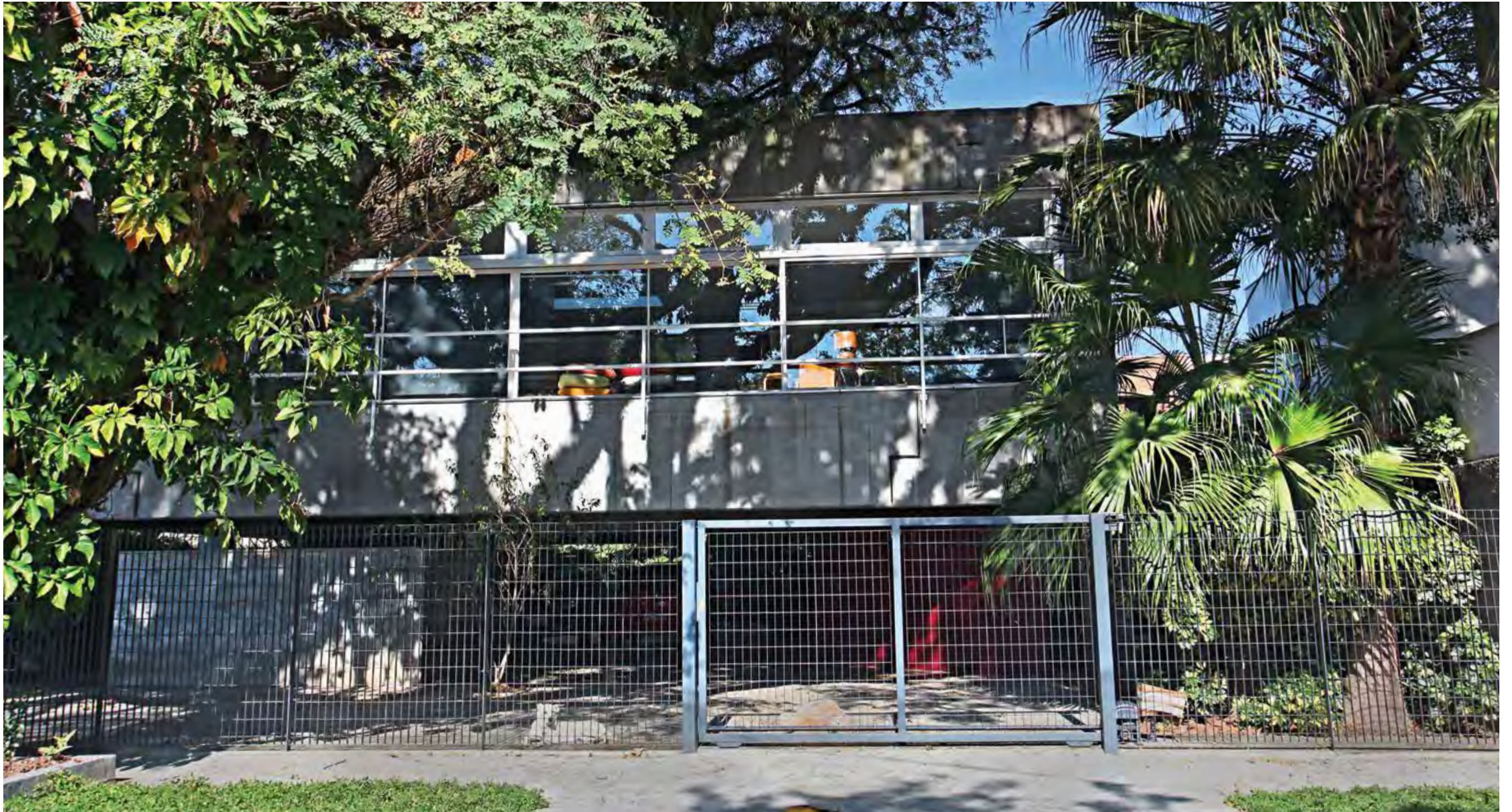
Casa na rua Carlos Norberto de Souza Aranha, arquiteto Paulo Mendes da Rocha
